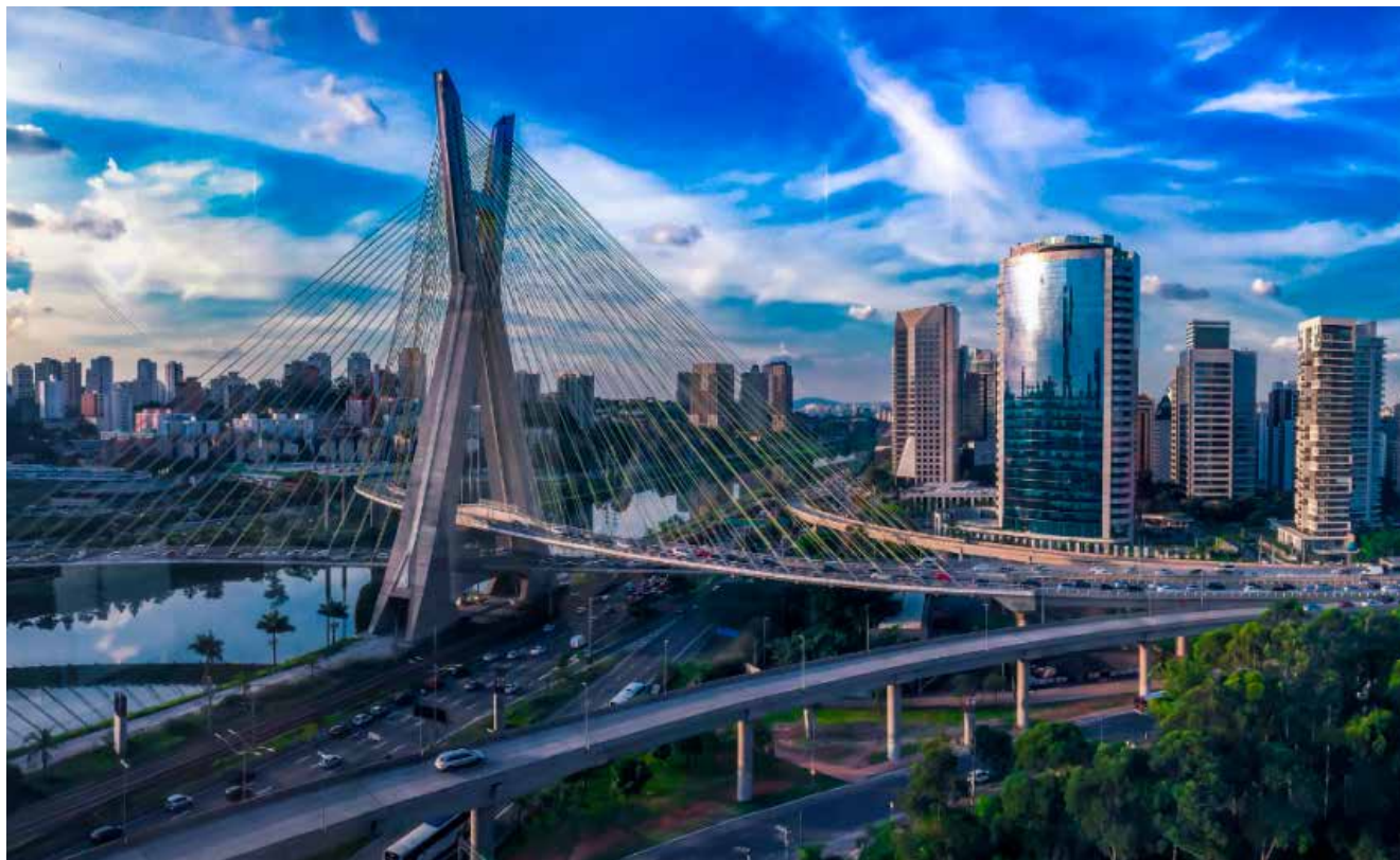
Figura 2 – Ponte Estaiada Octávio Frias de Oliveira Fonte: Falcão Bauer, 2021.
