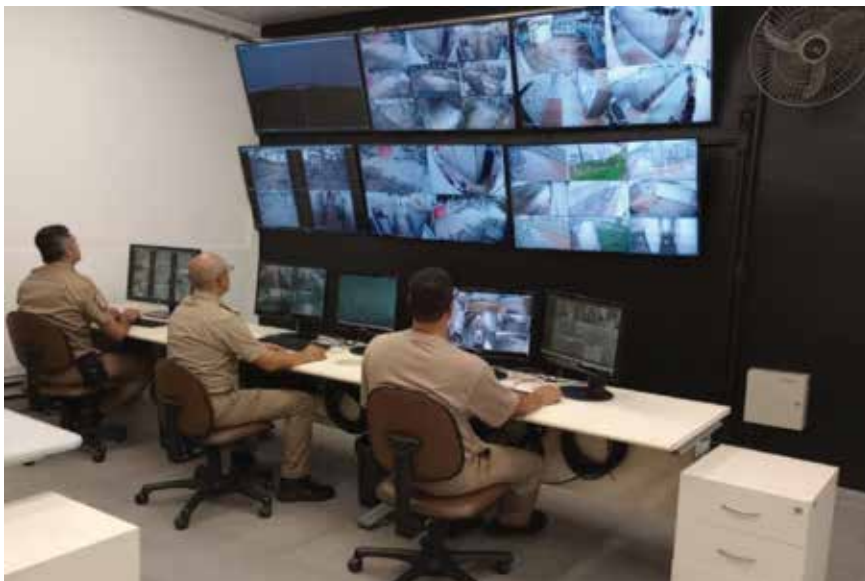
Central de Monitoramento da Segurança Patrimonial – CMSP
