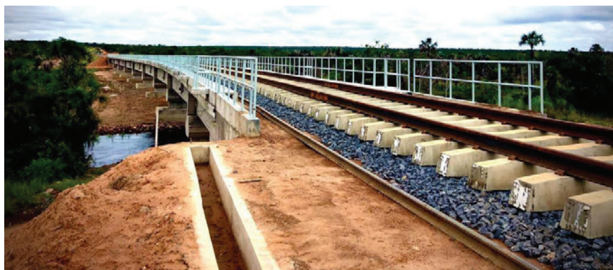
Obras da FIOLO II no lote 05 em Guanambi/BA
