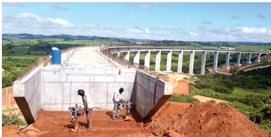
Obras da FIOLO II no lote 05 em Guanambi/BA
